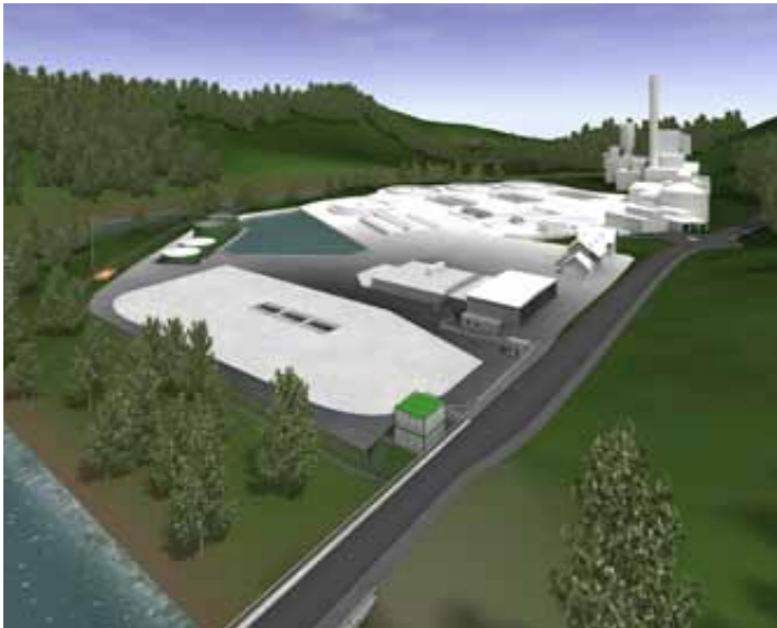
Für die Wahl des Standortes waren zwei Gründe entscheidend: Vom Bohrplatz Au ist das Zielgebiet – die mit den seismischen Messungen identifizierte «Störungszone» in Malm- und Muschelkalk – erreichbar, und ein direkter Anschluss des zukünftigen Geothermie-Heizkraftwerkes an das Fernwärmenetz ist möglich.
