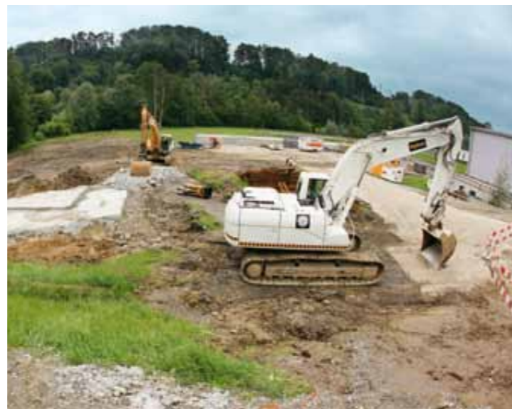
Die Bauarbeiten beginnen: Um den 18000 m 2 grossen Bohrplatz für die Bohranlage und die Tiefbohrungen vorzubereiten, waren zahlreiche Massnahmen erforderlich.
