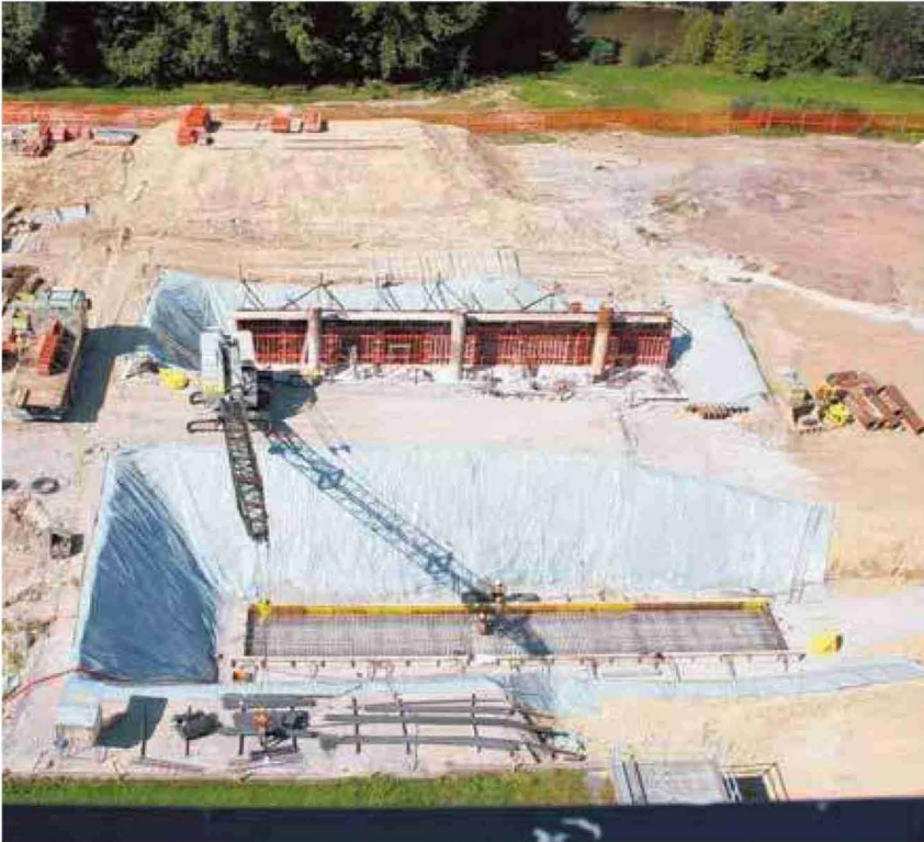
Der Bauplatz für die Geothermie bei der ARA Au-Bruggen aus 30 Metern Höhe.
