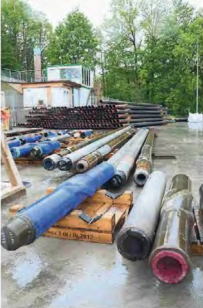
Die Gestänge für die Geothermie-Bohrung.
