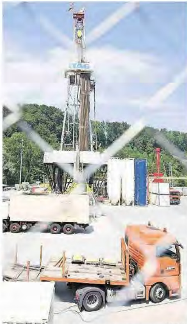
4500 Meter in die Tiefe gebohrt: Geothermie-Bohrturm in St.Gallen.
