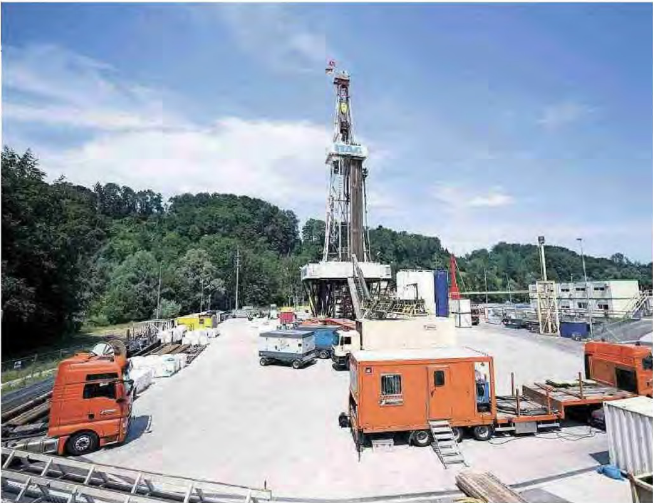
Geothermie-Areal im Sittertobel: «Die Risiken der Geothermie sind abschätzbar und in den Griff zu bekommen», sagt Befürworterin Kathy Riklin.
