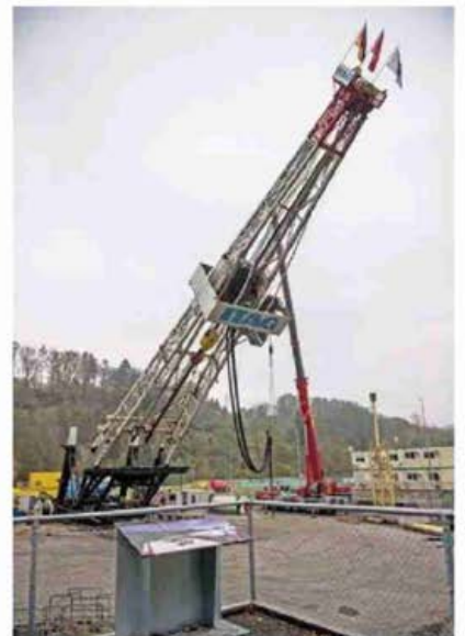
Der Turm des Geothermieprojektes. KEY
